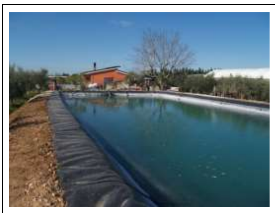
Fig. 2 – Laghetto artificiale per la raccolta dell'acqua piovana a scopo irriguo.
