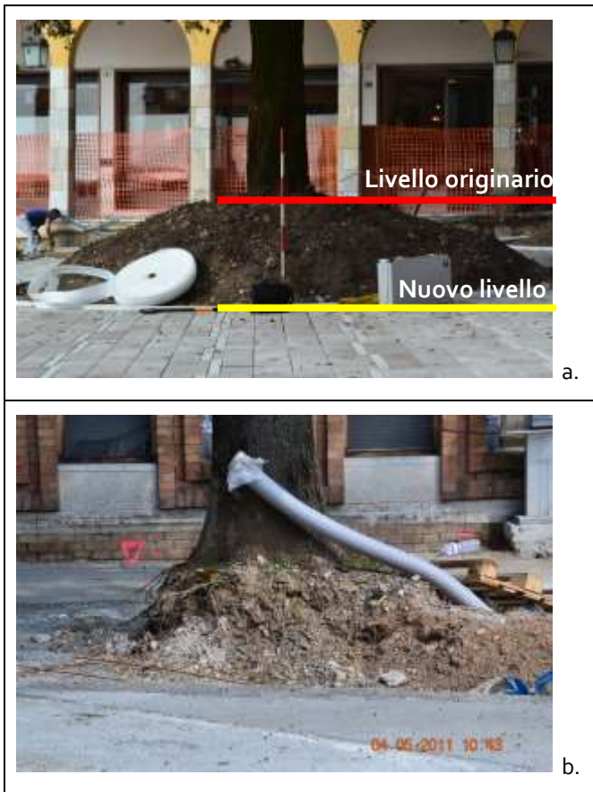
Fig. 2 – Scavi intorno ad una pianta per abbassare il livello della quota del piazzale. Sopra, livello abbassato di 80 cm eliminando quasi completamente l'apparato radicale assorbente di un leccio; sotto, scavi intorno ad un olmo per abbassare il livello del piazzale di circa 40 cm.
