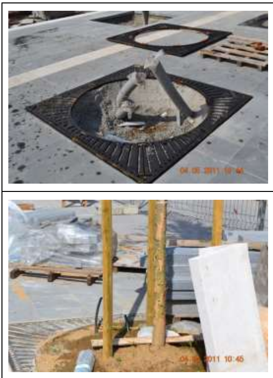
Fig. 1 – Realizzazione di nuovo verde urbano in cui si è badato solo all'aspetto estetico e non a quello agronomico.
